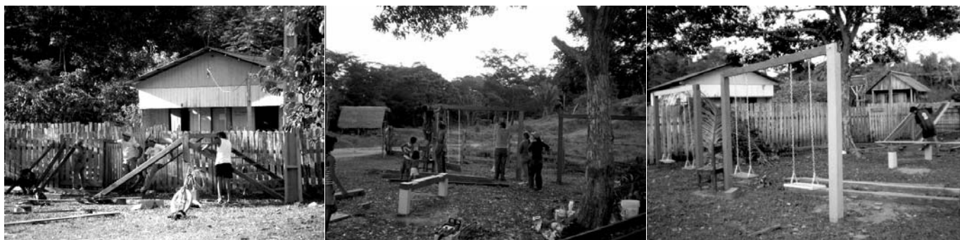
Fotos 04, 05 e 06 - Voluntários, em mutirão, construindo o parque infantil em frente da Escola São Pedro.
